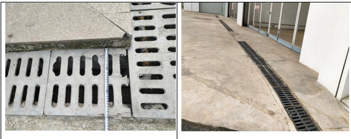
图 4-1 2022 年 6 月对排水进行现场检查，外观：线性流畅；效果：排水顺畅，满足排水要求；保存完好。
